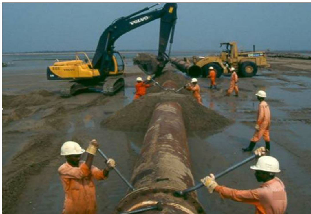
Instalarea unei conducte de reinnisipare. Exemplu
