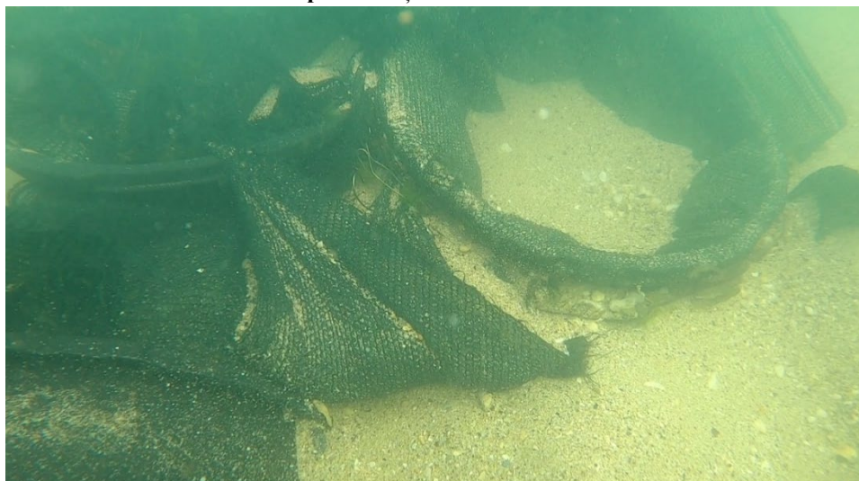
Aspect al coșurilor deteriorate
