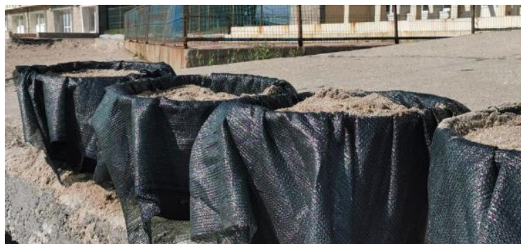
Aspect din timpul umplerii cosurilor cu nisip uscat
