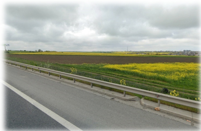
Figura nr. 49: Alternativa Techirghiol, zona km 0, Nod Rutier Cumpana, traversare peste A4 (km 18+500), imagine spre nord, spre Lazu
