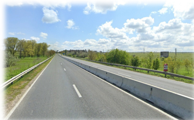
Figura nr. 62: Alternativa Techirghiol, zona km 28+460, intersectie cu DN 39 / E 87, zona Nod Rutier, imagine spre sud, la sud de 23 August, catre Mangalia
