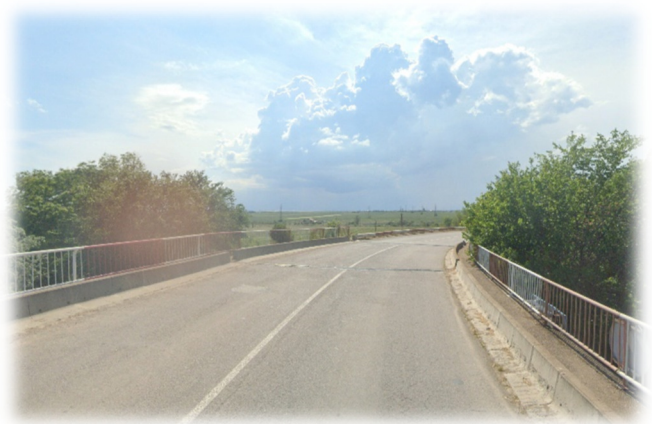
Figura nr. 68: Drum de legatură, zona km 0+500, intersecție cu DN 39, E 87 și DN 39A, imagine de pe pasajul existent peste DN 39, spre vest, spre Alternativa Techirghiol
