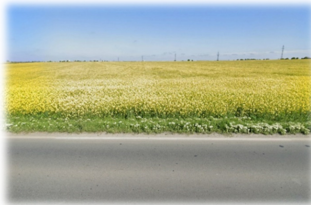
Figura nr. 72: Drum de legatura, zona km 2+620, intersectie cu DN 38, E 675, imagine spre est, spre Eforie Nord
