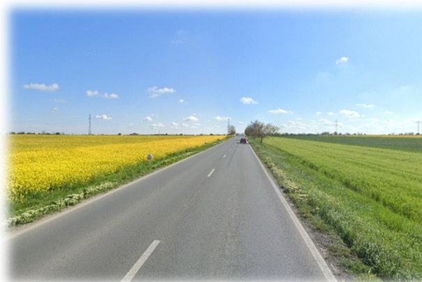
Figura nr. 74: Drum de legatura, zona km 2+620, intersectie cu DN 38, E 675, imagine spre sud-vest, spre Techirghiol
