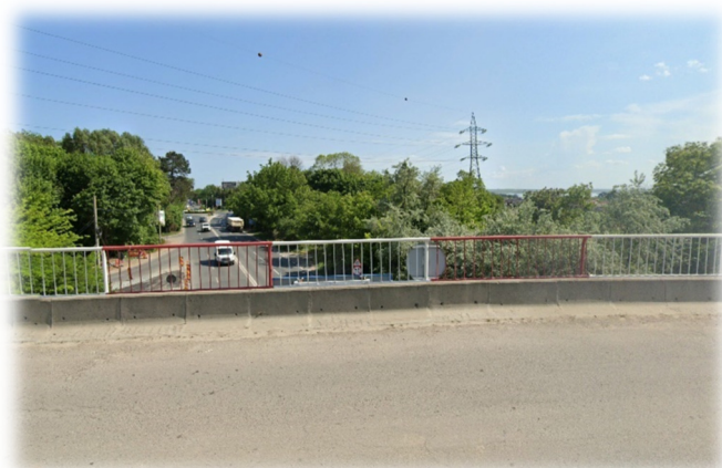
Figura nr. 70: Drum de legatură, zona km 0+500, intersecție cu DN 39, E 87 și DN 39A, imagine de pe amplasamentul actual la pasajului peste DN 39, imagine spre sud, spre Eforie Nord
