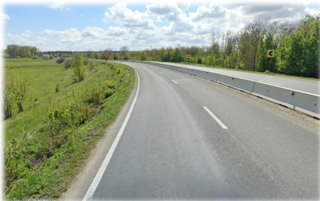
Figura nr. 60: Alternativa Techirghiol, zona km 28+200, intersectie cu DN 39 / E 87, zona Nod Rutier, imagine spre sud, la sud de 23 August, catre Mangalia
