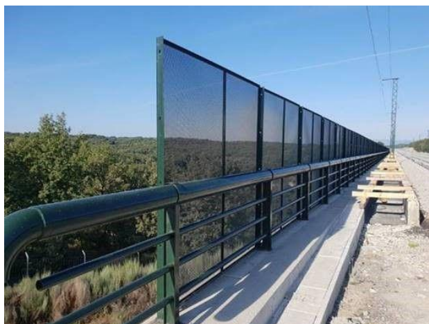
Figura nr. 5-9 Exemplu de panouri anticoliziune (atenție, panourile din exemplu nu au înălțimea de 3m)
