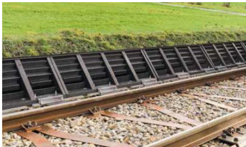
Figura nr. 2-5 Exemplu de sistem de protecție împotriva zgomotului montat pe traversă
