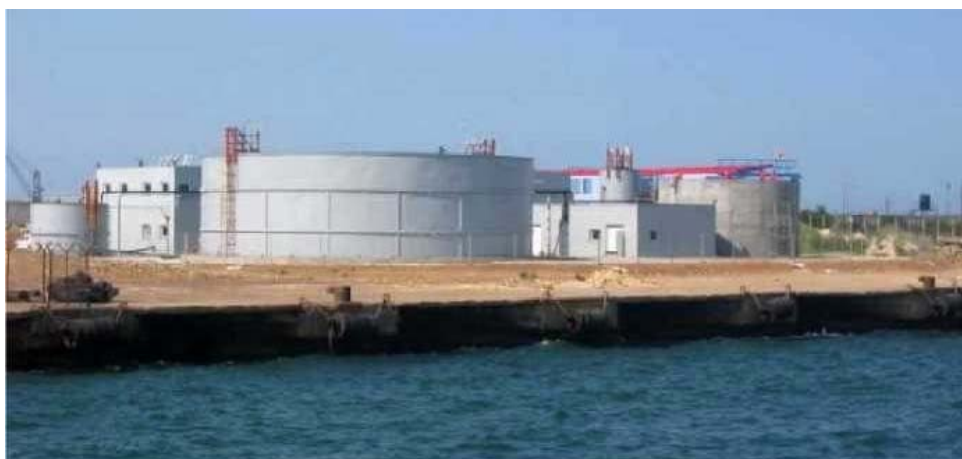
Foto 16. Statia de epurare ape uzate
