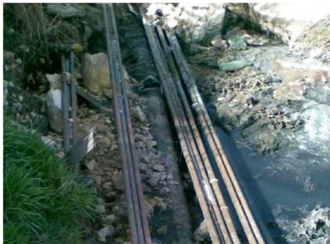
Foto 11. Amplasare conducta de canalizare sub presiune
