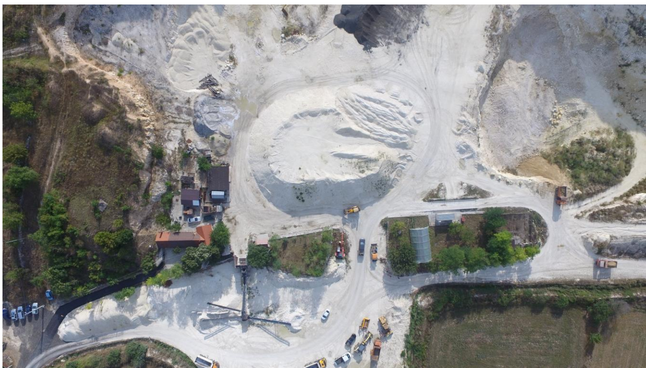
Figura 16. Imagine de ansamblu asupra vetrei de carieră la nivelul căreia se disting: zona organizării de șantier, stația de concasare/sortare, conurile de depozitare a sorturilor obținute, utilajele de lucru
