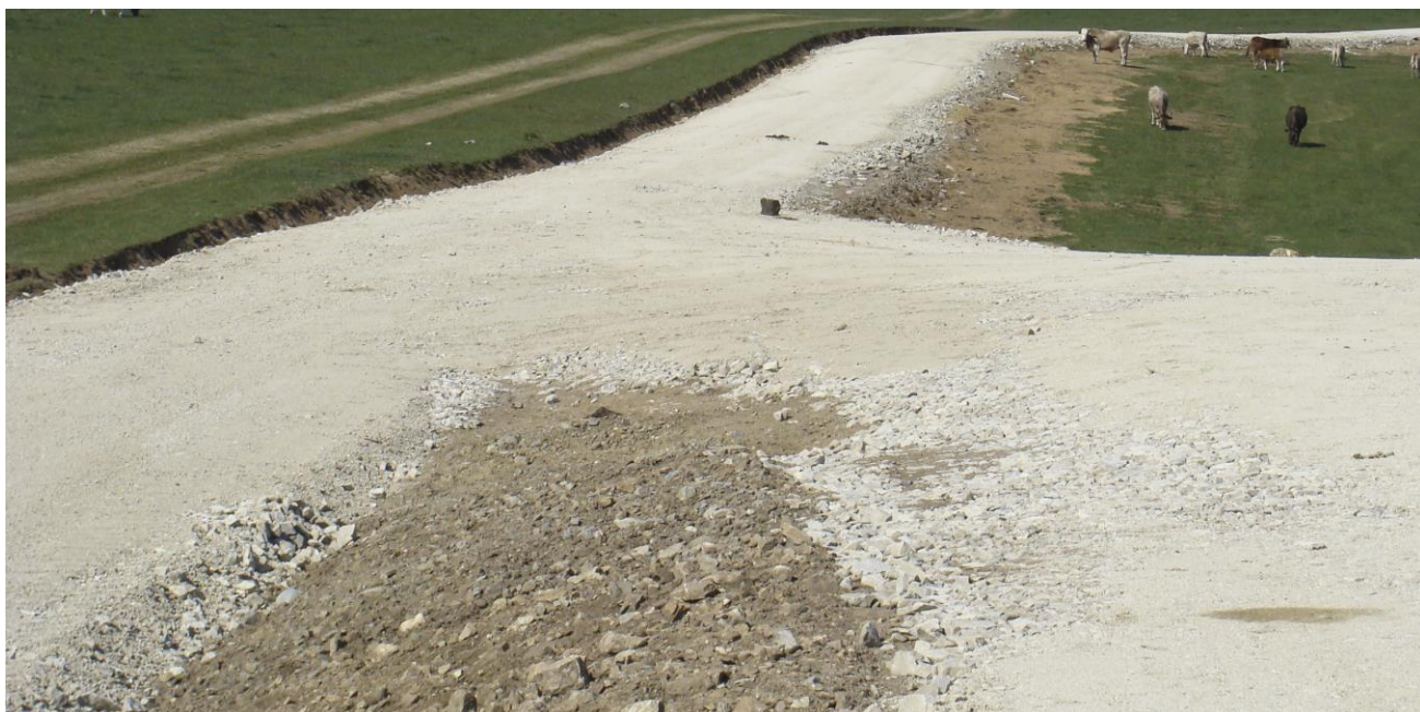
Figura 37. Aspect al unui drum de pământ consolidat cu anrocamente din calcar (zurai)
