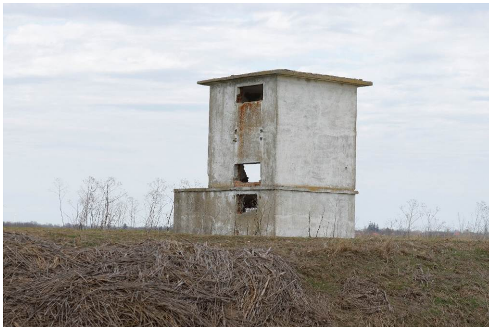
Fosta statie de pompare pentru irigare (foto original SCBIM AON)
