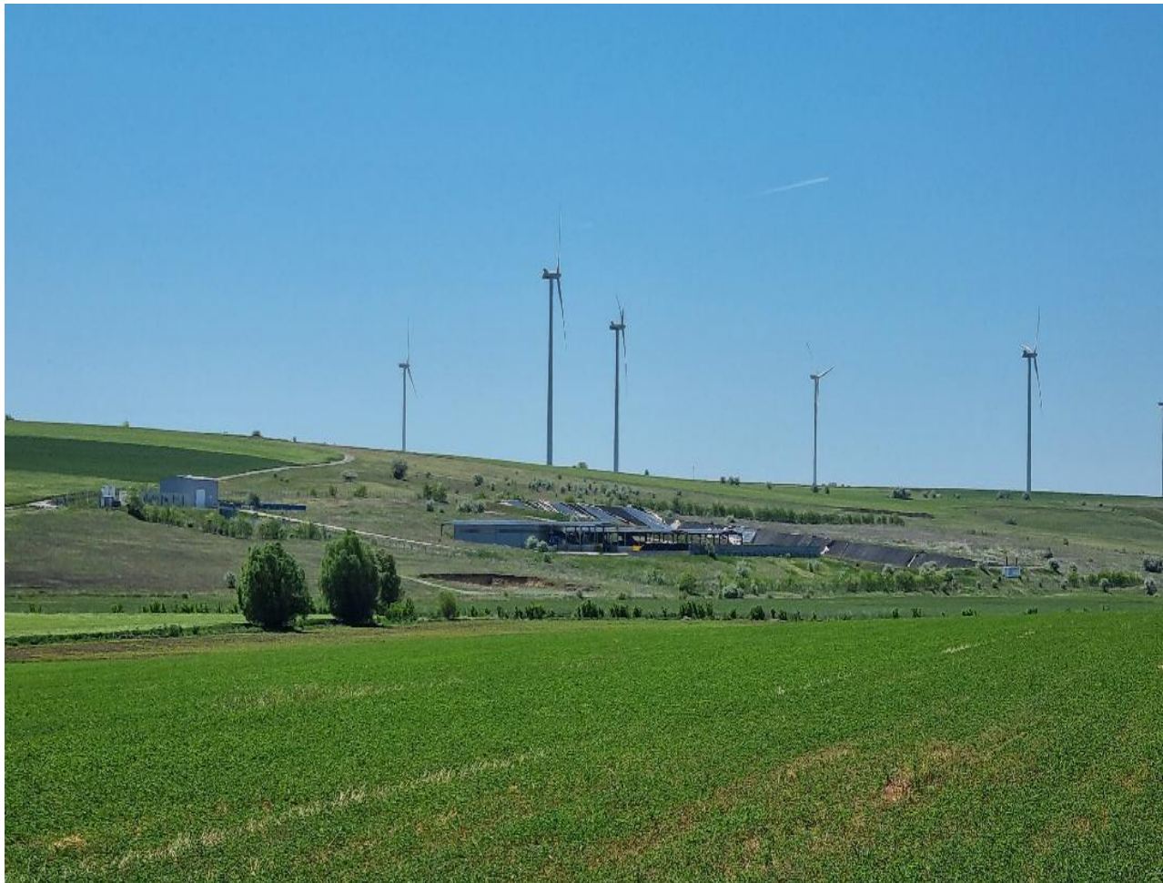
Fig. nr 9 Stația de sortare Tortoman, aflată la aprox 1 km Sud- Vest de terenul studiat (foto realizată în data de 21.05.2022)
