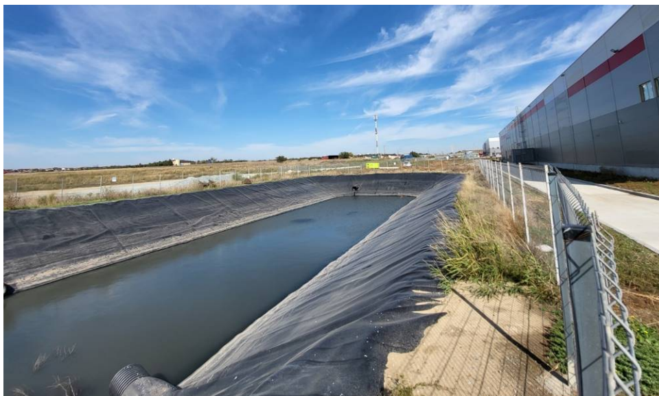
Foto: Bazin retentie cu capacitatea de 1400 mc (partea de vest a amplasamentului)
