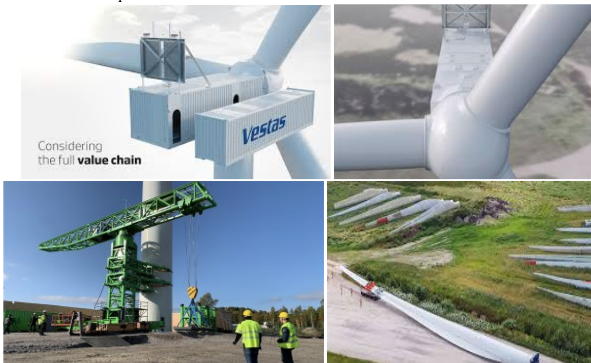
Imagini de la realizarea unui parc eolian cu turbine VESTAS
