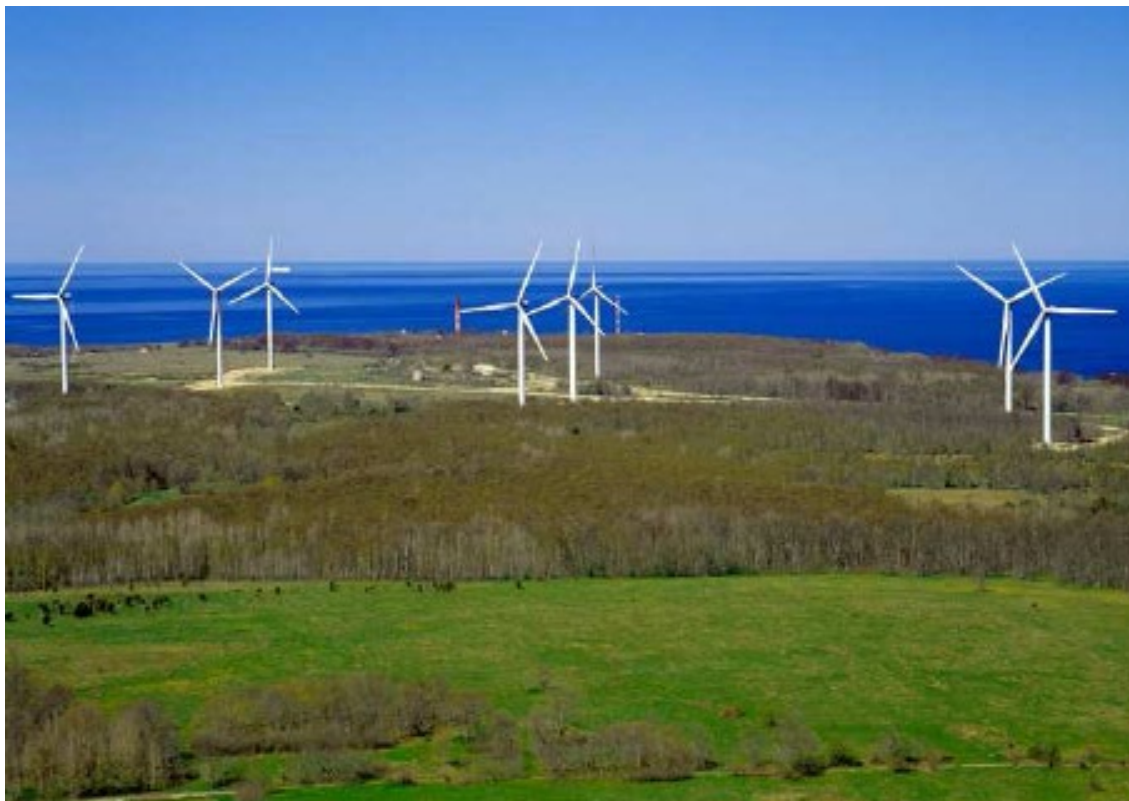
Eoliene cu ax orizontal cu rotorul de tip elice
