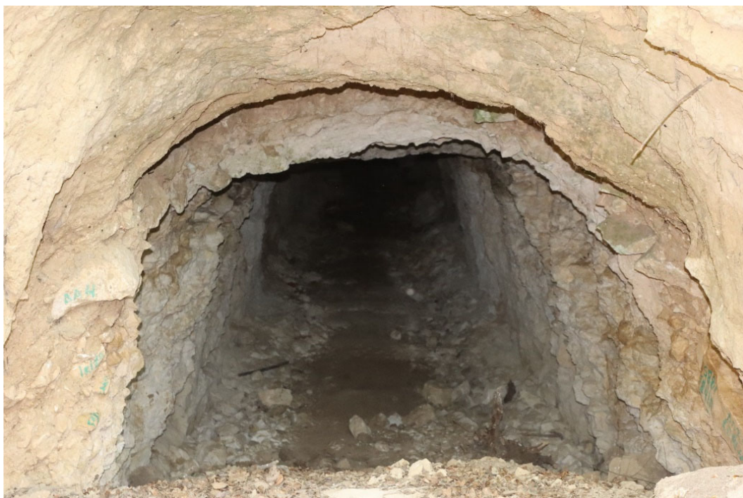
Aspect al intrării in galeria de mina ((foto original SCBIM AON)
