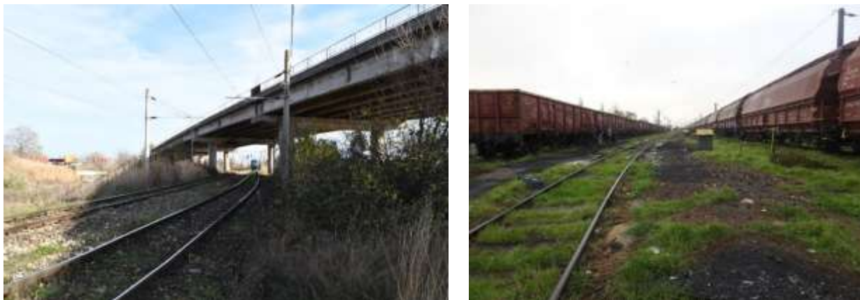
Figura nr. 5-2 Imagini din zona amplasamentului
