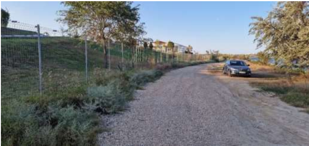
Fig. 3. Drum pietruit pe amplasamentul căruia va fi edificată pista pentru biciclete și aleea pietonală
