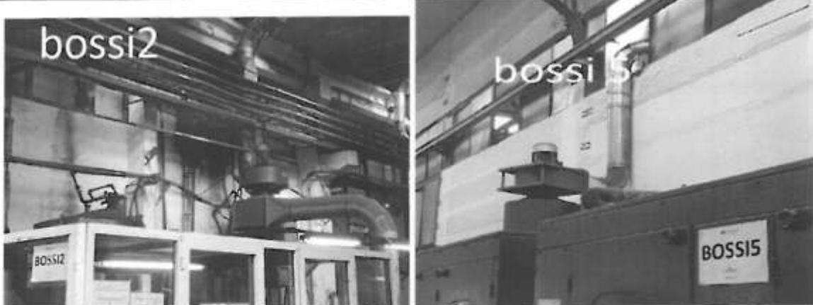
Masina de debitat cu panza sau disc este conectata la un sistem de captare mecanica racordata la un ventilator de 2000 m<sup>2</sup>/h prevazut cu un ciclon si filtre cu saci de colectare inainte de evacuare – centralizat la o inaltime de 9m d=0,3 m
