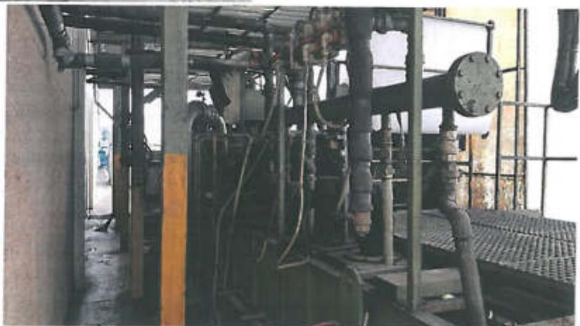
Instalatie centralizata de filtrare sub presiune si racire emulsie necesara pentru: – retinere pilitura si particule abrazive provenite de la instalatiile de rectificare
