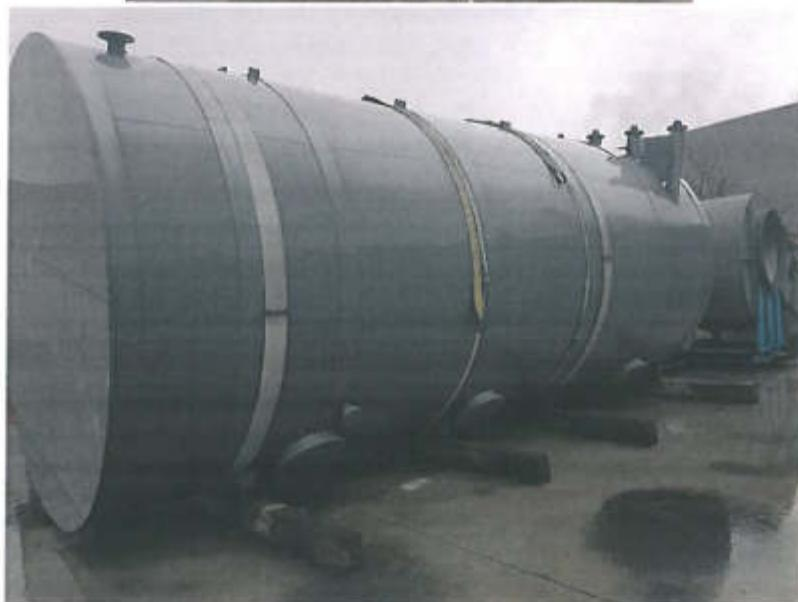
**4. Instalatie de pregatire materie prima (Anhidrida Cromica) necesara pentru: – completare cu solutie de electrolit pentru mentinere nivel instalatii de cromare**
