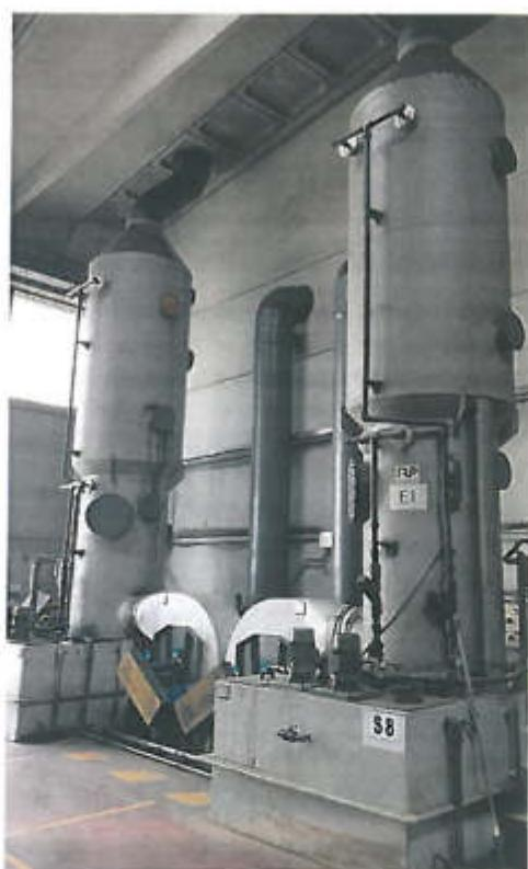
Instalație de aspirație tip Scrubber centralizat necesara pentru: – reducerea emisiilor C.O.V
