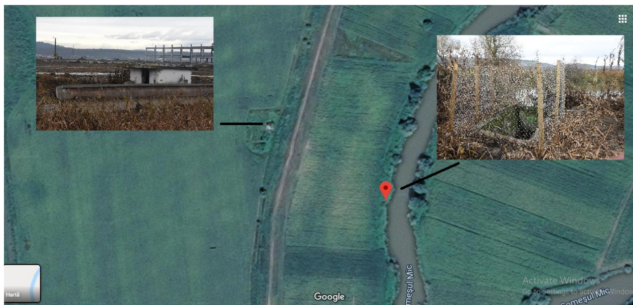
Figura 7. Sistem de preluare apă abandonat (în stânga este casa pompelor, de la care merge o conductă veche de 800mm diametru (până la Captare - poza dreapta)
