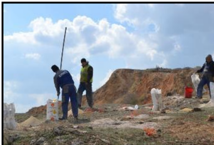
Încărcarea găurilor cu nitramoniu
