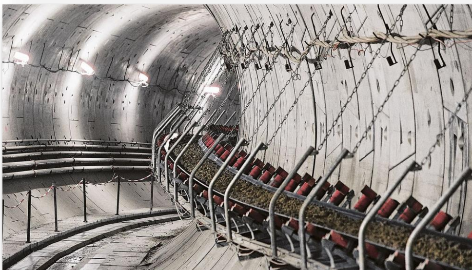
Figura 1.155. Transportor cu bandă pentru material excavat în interiorul tunelului
