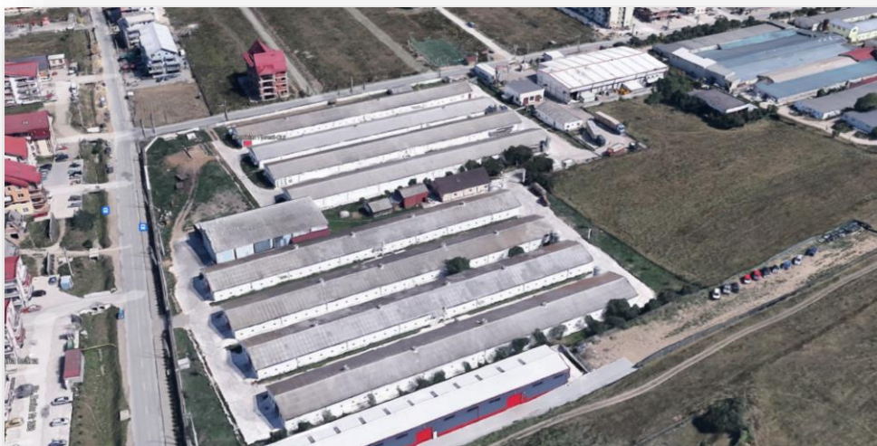
Figura 1.134. Amplasament și vedere imobil situat pe Str. Eroilor și Str. Cetății nr. 101-103
