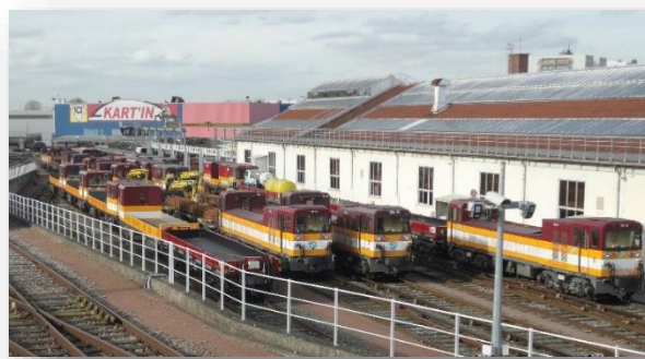
Figura 1.126. Exemplu de zonă de pregătire a trenurilor de lucru în cadrul unui Atelier de Reparații Infrastructură
