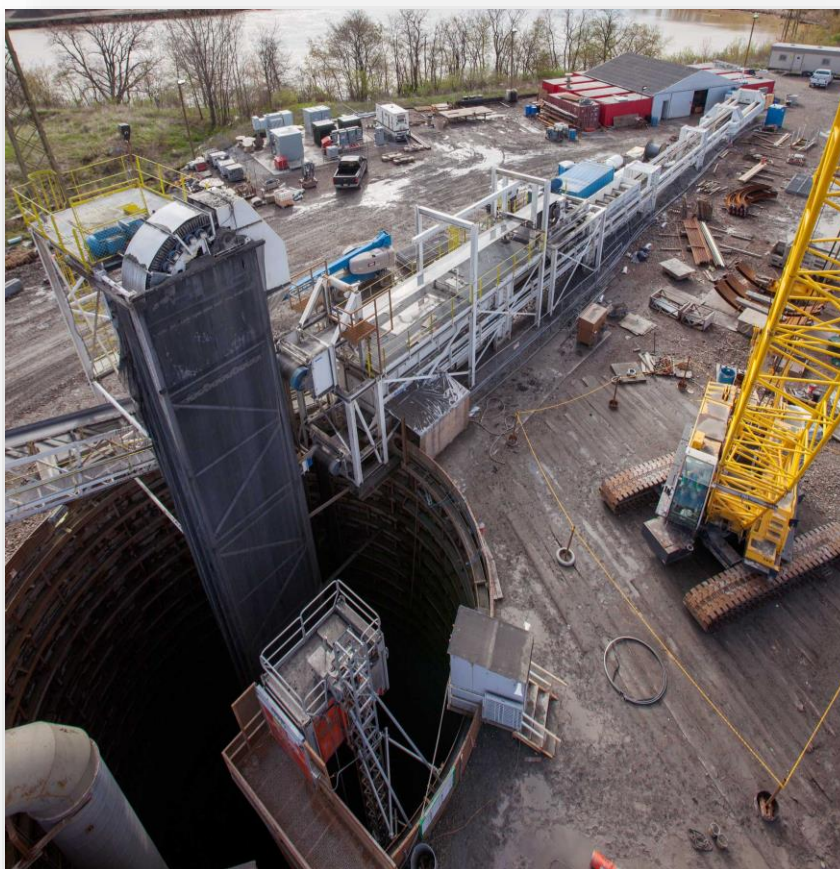
Figura 1.155. Transportor cu bandă pentru material excavat în interiorul tunelului
