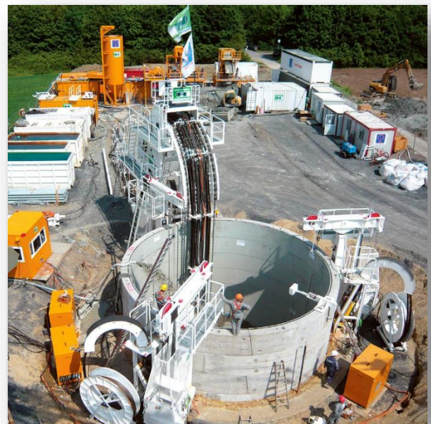
Figura 1.19. Santier tipic pentru VSM
