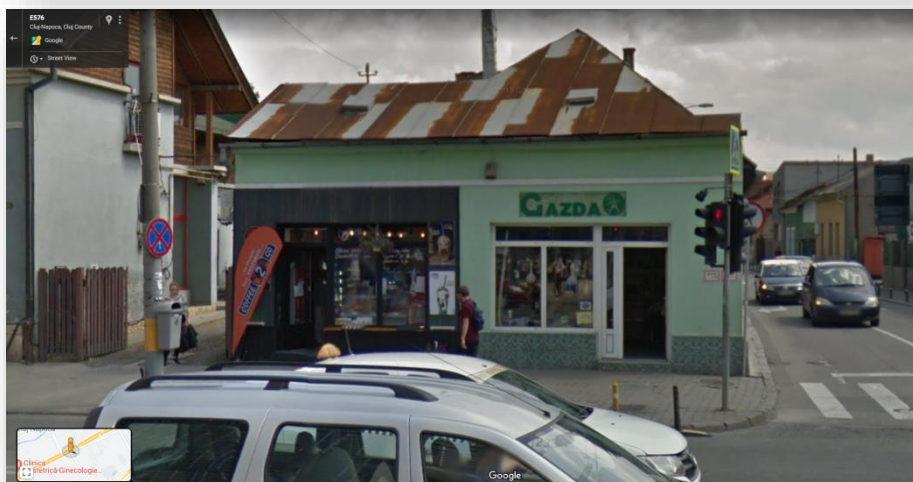
Figura 1.143. Amplasament și vedere imobil situat pe B-dul 21 Decembrie 1989 nr. 116, clădire vest
