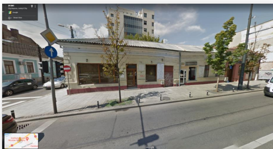
Figura 1.141. Amplasament și vedere imobil situat pe Calea Moților nr. 40
