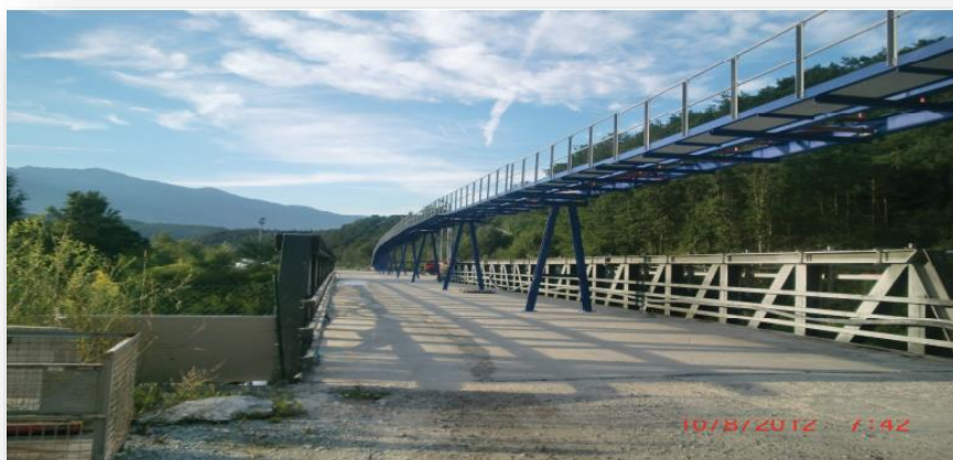
Figura 1.154. Transportor cu bandă pentru material excavat în afara tunelului
