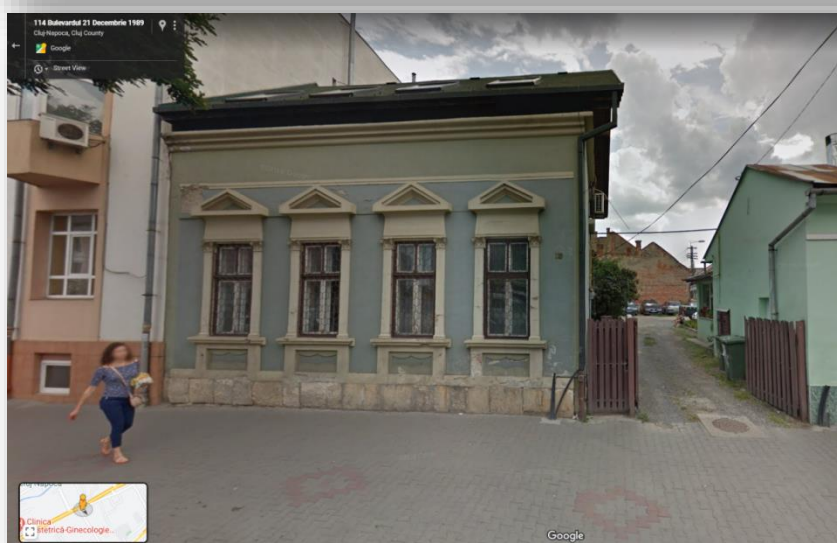
Figura 1.144. Amplasament și vedere imobil situat pe B-dul 21 Decembrie 1989 nr. 116, clădire est
