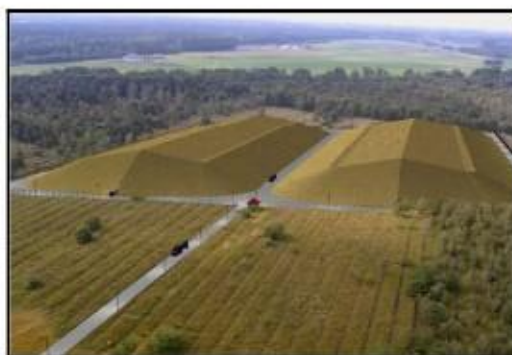
Figura 10 Depozit sigilat, modular construit sub forma de canal cu manta protectoare cu bariere multiple.
