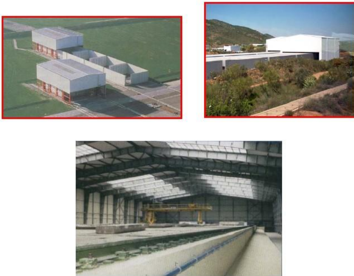
Figura 12 Depozite moderne pentru deseuri radioactive de intensitate mica si medie cu structuri de protectie pe perioada operarii a) Centrul La Obe – Franta, b) El Cabril – Spania, c) Mochovce – Slovacia.
